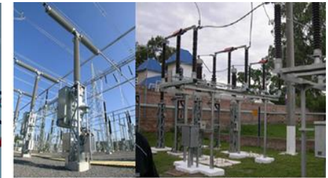
Izquierda: imagen de un interruptor. Derecha: imagen de varios seccionadores.
