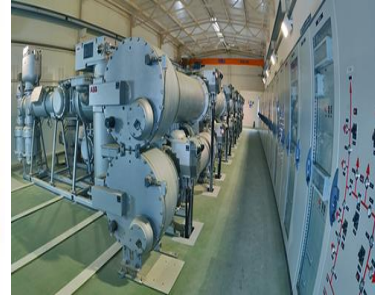
Izquierda: imagen de un interruptor. Derecha: imagen de varios seccionadores.
